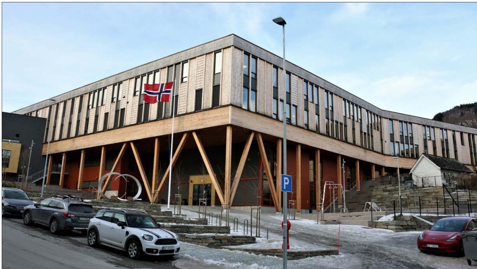
Den nye skulen i Norheimsund er på 9.000 kvadratmeter. Prislapp: 600 millionar kroner. I tillegg til vidaregåande skule, er det bibliotek, kino, kulturskule og vaksenopplæring. Og som ein ser er tre eit mykje nytta byggmaterial.
